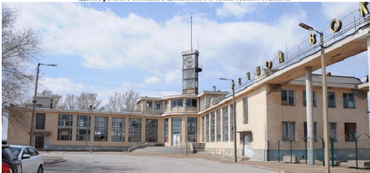
здание речного вокзала с цокольным и техническим этажами
