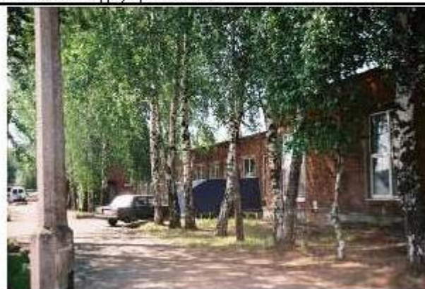
Здание цеха 4-х эт. Судоремонтный цех
