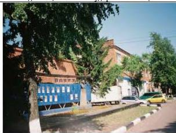
2-х эт. задние Кузнечно-котельный участок
