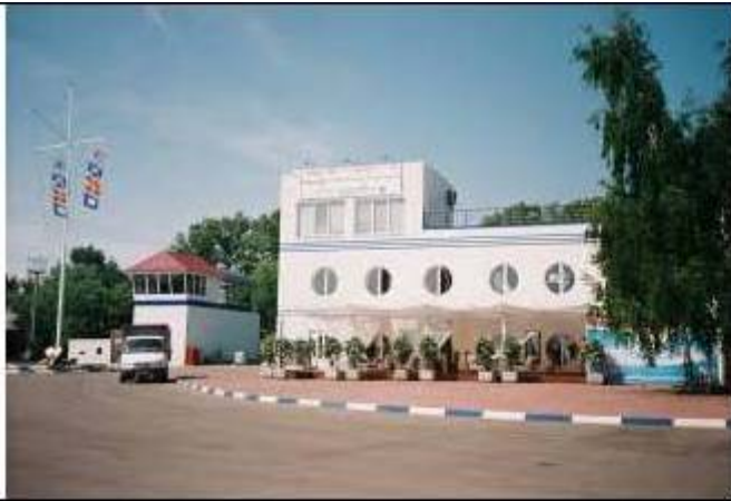
Судоремонтный цех – административное здание
