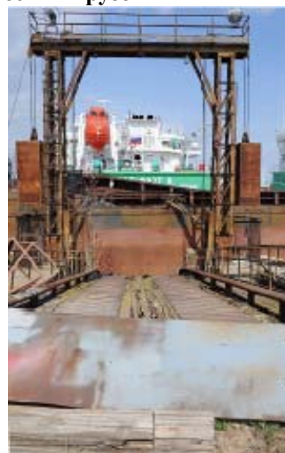
мост на жб опорах для выгрузки тяжеловесных грузов
