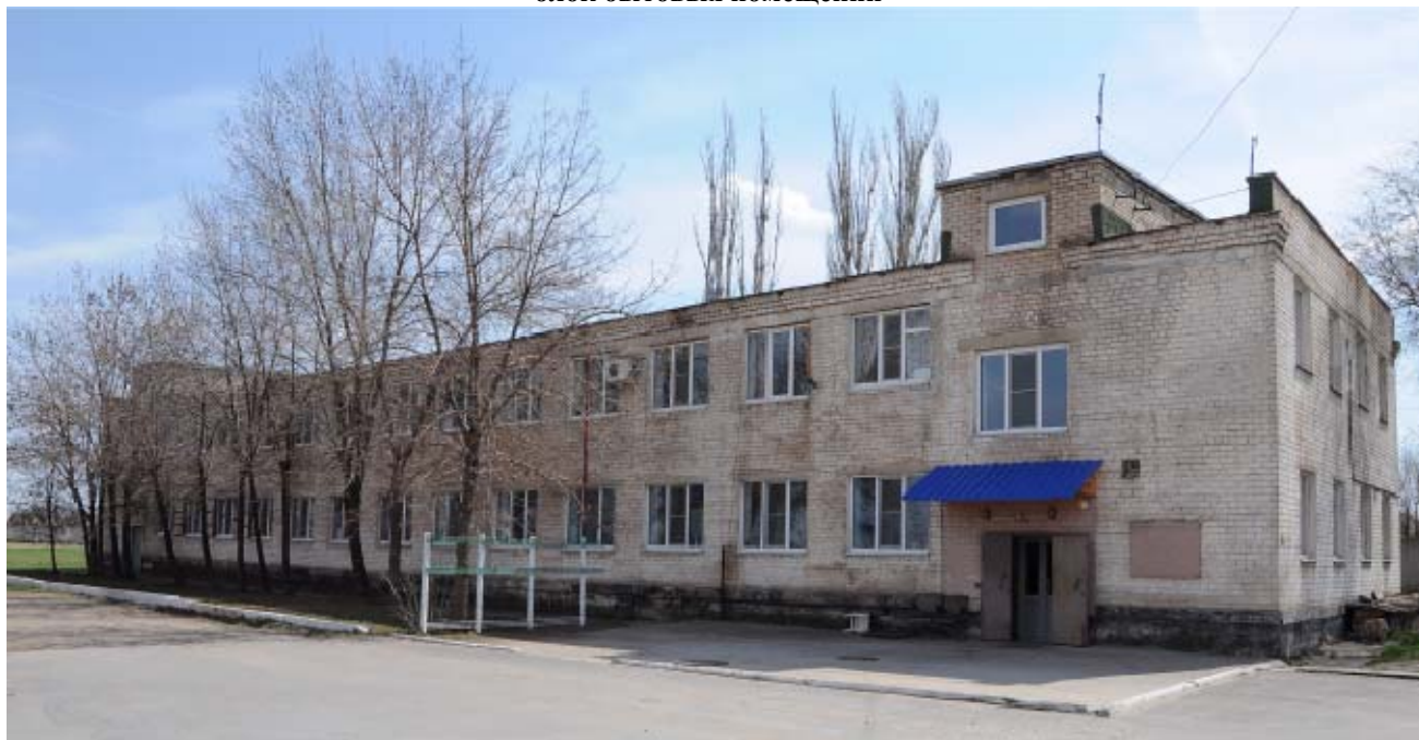
блок бытовых помещений
