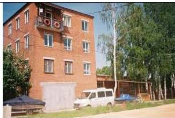
Здание цеха 4-х эт. Судоремонтный цех
