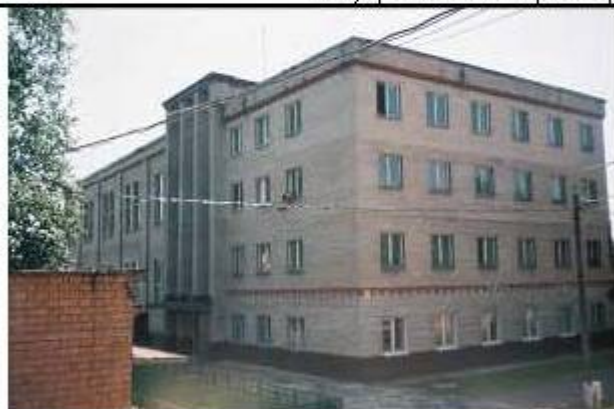
Здание 4-х эт. Заводоуправления
